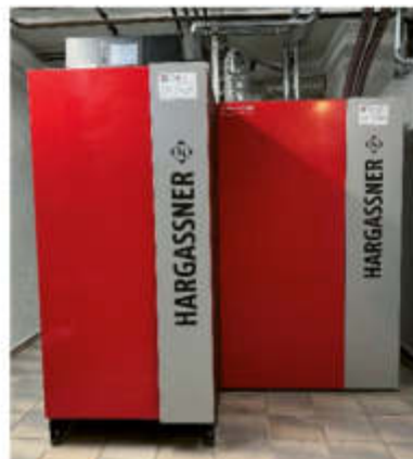
Installationsbsp.: Hargassner Kombianlage Stückgut / Pellets inkl. Sacksilos zur Pelletslagerung
